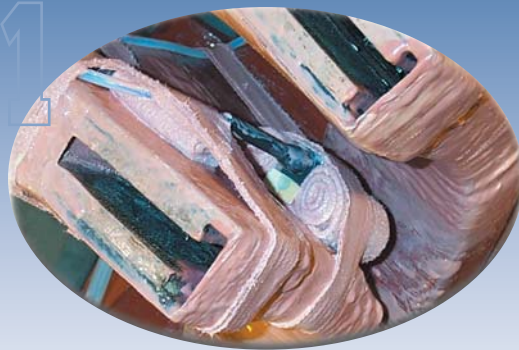
Установка FOA в лобовых частях обмотки турбогенератора
